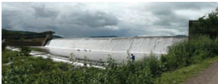
Panorámica de la presa.
