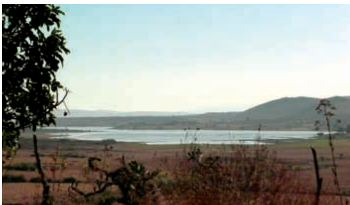
Presa de El Volantín.
