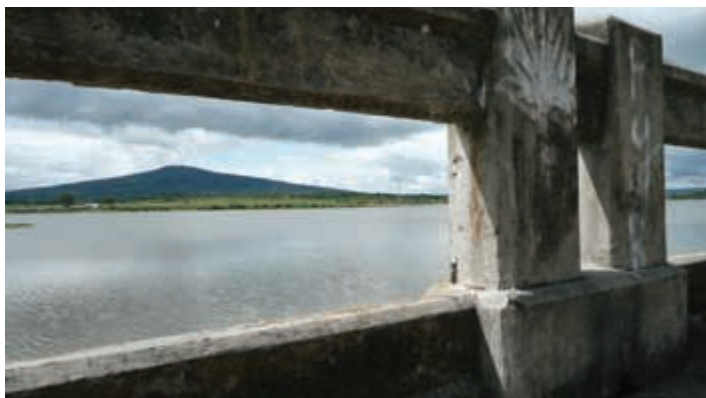
Paseo sobre la presa.
