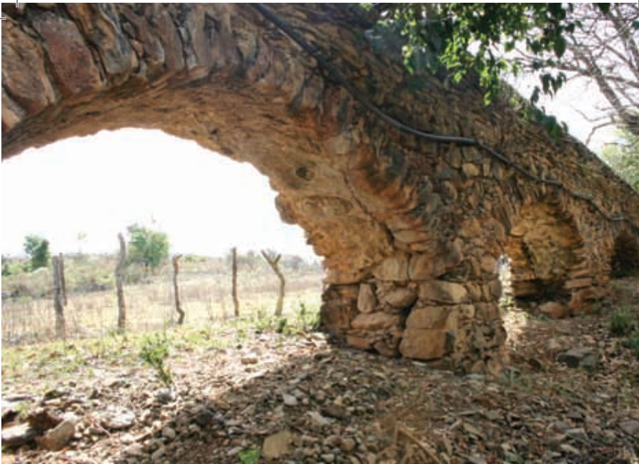
Acueducto virreinal de Toluquilla.
